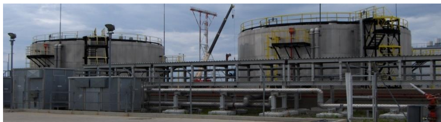
РЕЗЕРВУАРЫ ДЛЯ ХРАНЕНИЯ ДИЗТОПЛИВА
