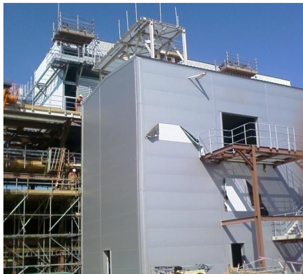
ЗДАНИЕ ХИМИЧЕСКОГО ДОЗИРОВАНИЯ
